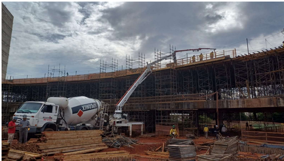
Foto 05 – Vigas de concreto armado.
