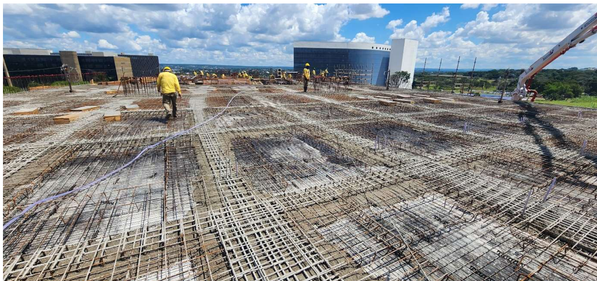
Foto 01 – Vigas de concreto armado.
