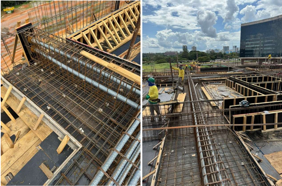
Foto 07 – Vigas de concreto armado.
