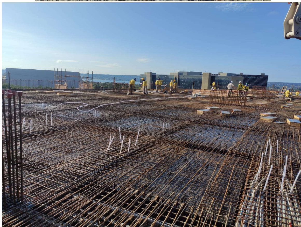
Foto 11 –Laje de concreto armado.
