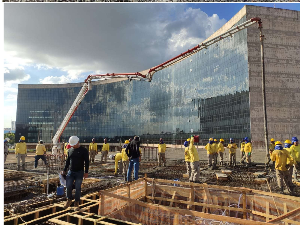
Foto 12 –Laje de concreto armado.
