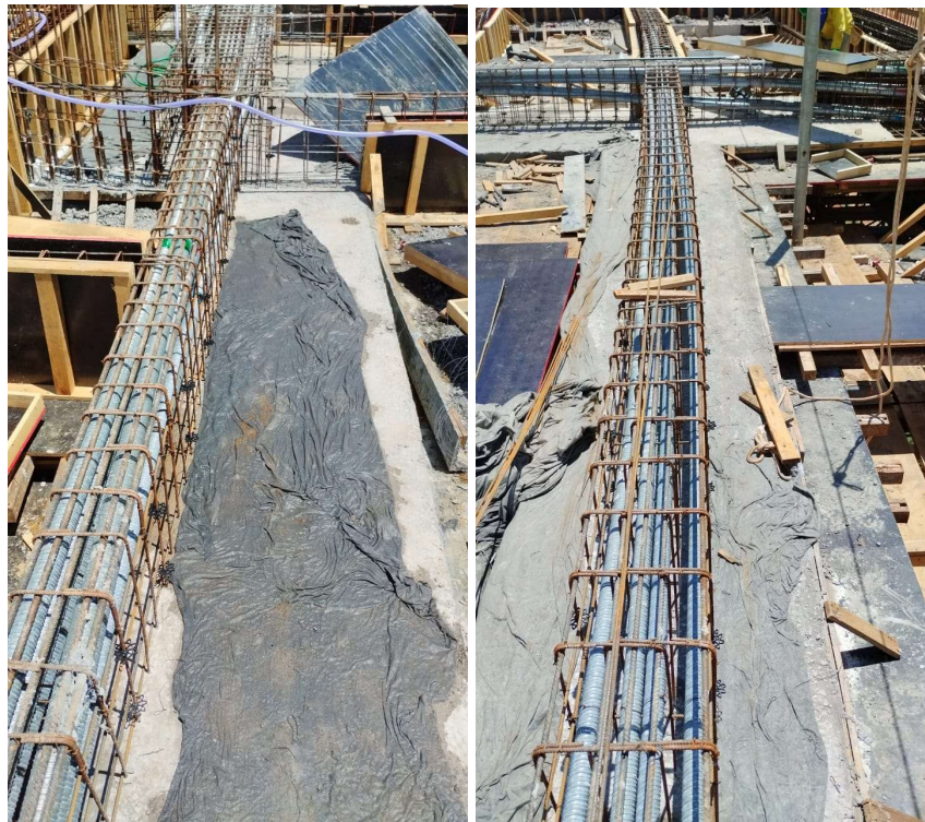
Foto 08 – Vigas de concreto armado.
